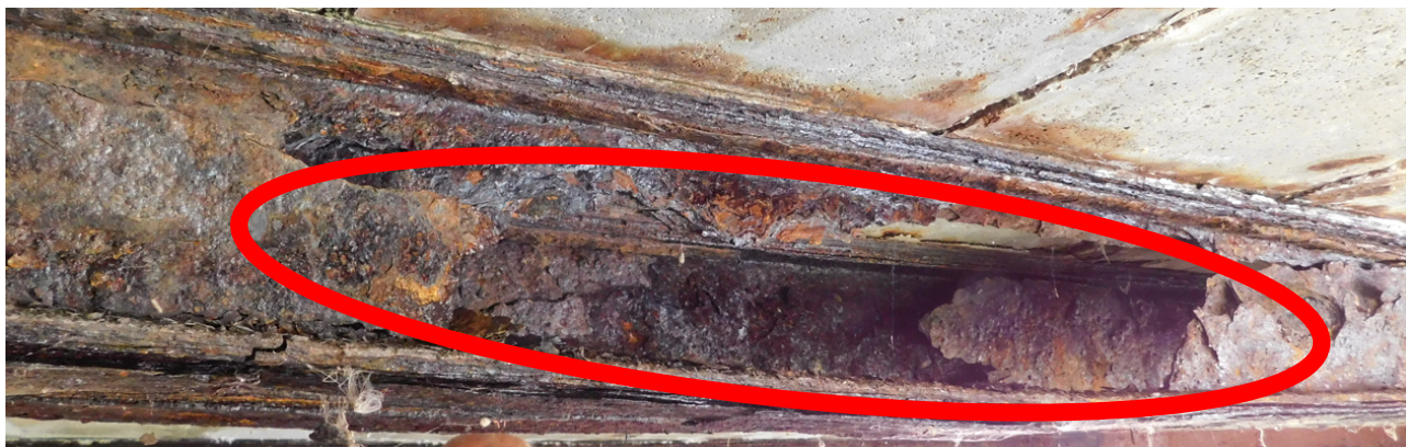
Foto č. 1 – korozivní oslabení (červeně vyznačeny ukázky chybějících částí konstrukce)
