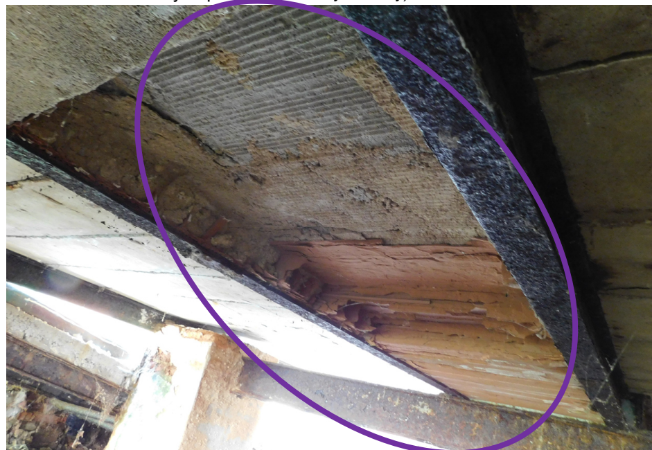
Foto č. 2 – zhroucení keramických panelů (fialově vyznačeny)
