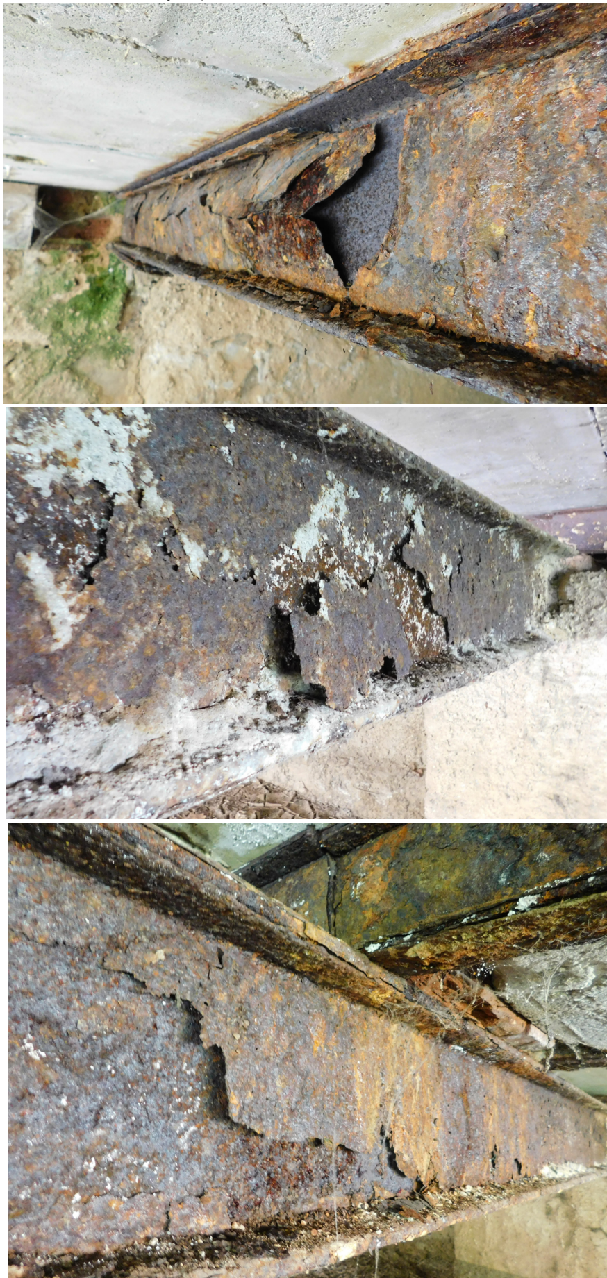
Foto č. 3 – ukázka koroze ocelových prvků
